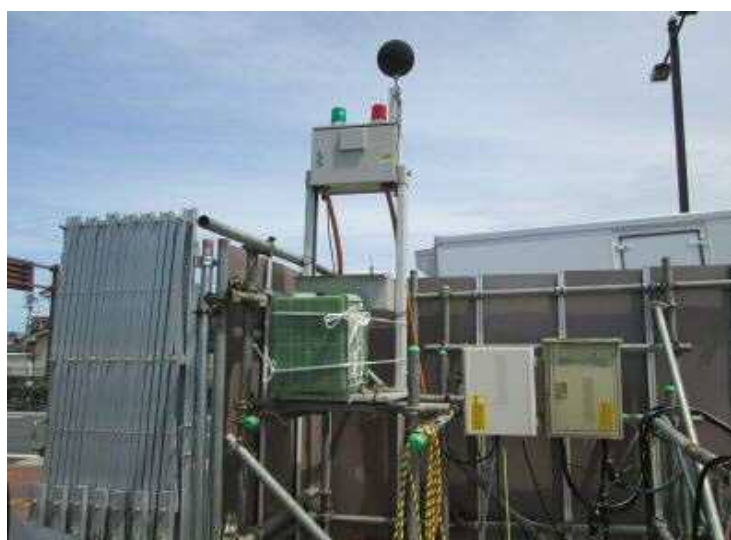
「雲太」：設置・稼働状況
