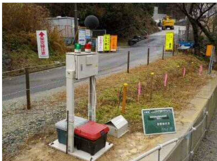
「雲太」：設置・稼働状況
