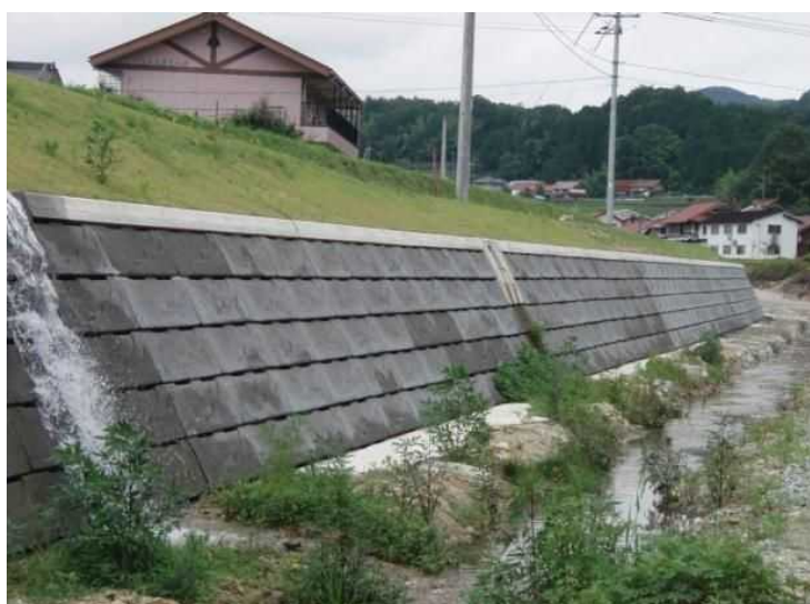
全景写真(下流部より撮影)
