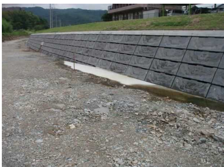
全景写真(上流部より撮影)
