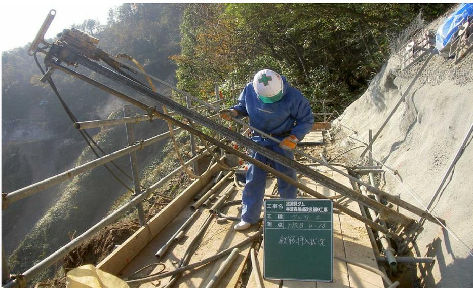
高所作業車を使用したベンチャードリル削孔
