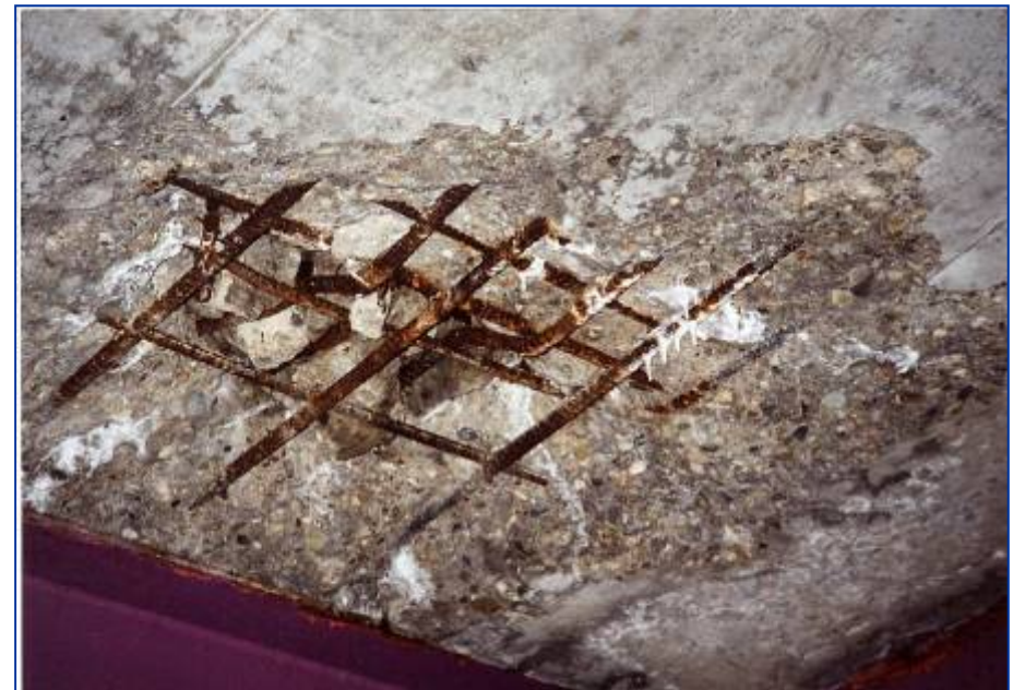
鉄筋の著しい腐食
