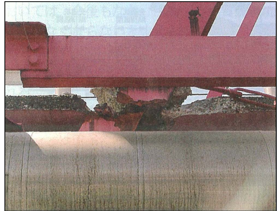
写真2 木曾川大橋の斜材破断 (2007年)
