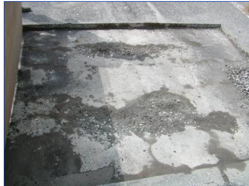
床版損傷(舗装はつり)
