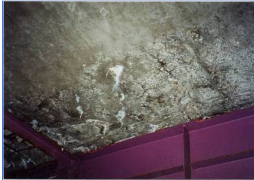
橋面からの漏水跡
