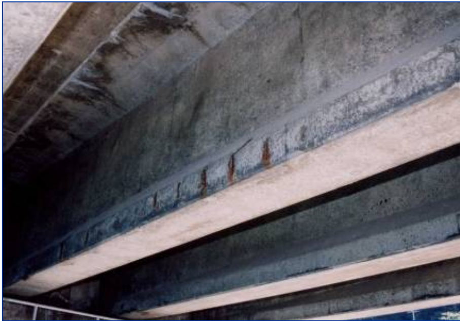
PCT桁鉄筋の露出
