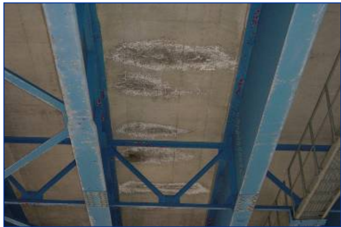
床版下面に漏水・遊離石灰
