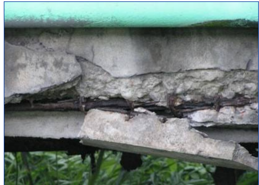
RCT桁 主鉄筋の露出
