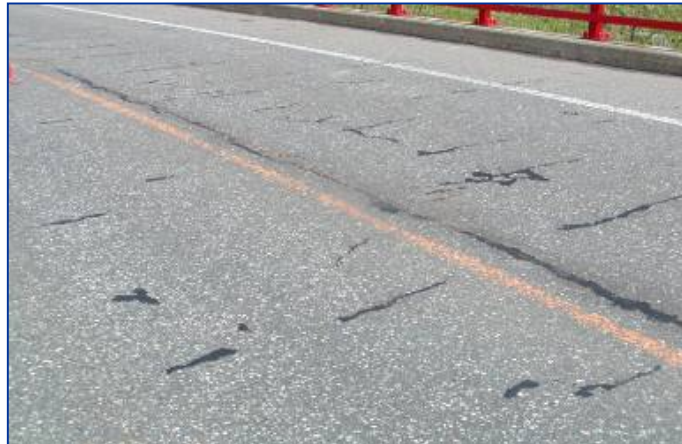
舗装面に多くのひび割れ
