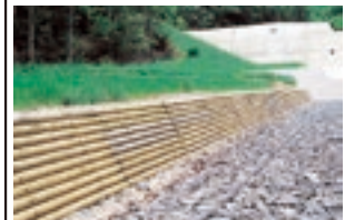
製品施工例（流路工）
