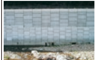
スーパーテールアルメ（上段）、 アクアテール35（下段）の施工例
