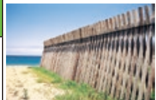
製品施工例（防風柵）
