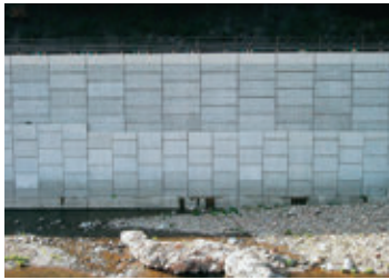
スーパーテールアルメ(上段)、 アクアテール35(下段)の施工例
