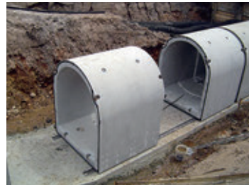
製品の施工例「アーチカルバート」
