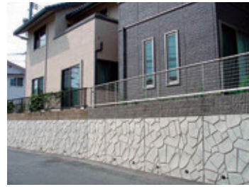
製品の施工例「CHウォール」
