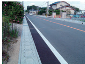
製品の施工例「道路側溝M(無騒音)」
