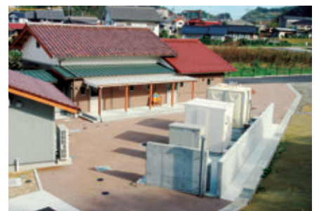
デイサービスセンター「からおと苑」の舗装整備 (製品:東幸建設(株)のワックファルトナチュラル)
