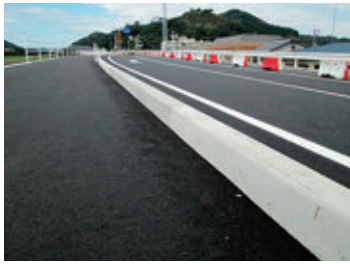
製品の施工例「防草ブロック」
