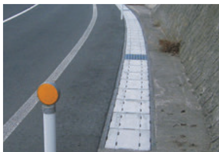
松江市内の側溝整備 (製品:和光産業(株)の側溝蓋)
