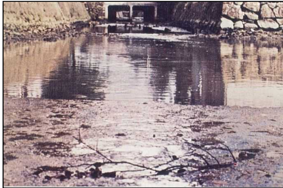
【昭和40年代の松江堀川】 生活雑排水の流入により堀川の水質が急速に悪化し、堀川流域の一部では、大きく景観が損なわれていました。
