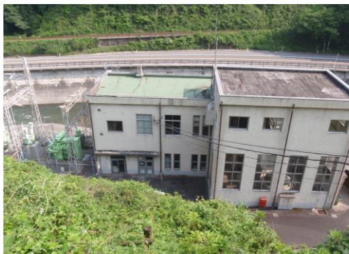
三成発電所 着工前
