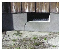
③基礎部分の調査
