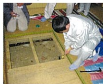
⑥床下調査 (床下点検口や下の床板を外して確認します)
