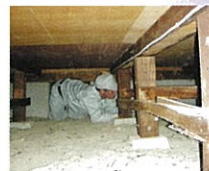
⑥床下調査 (床下点検口や下の床板を外して確認します)
