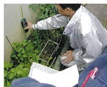
②外周調査 (デジタル探知機等を使用し筋かいの位置や基礎の鉄筋の有無も確認します)
