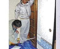
④室内調査 (建物の傾きも調べます)
