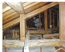
⑤小屋裏・天井裏調査 (天井点検口や押入などの天井から確認します)
