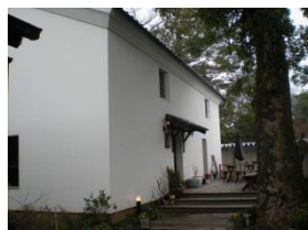
蔵を改修した店舗
