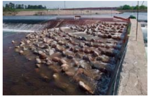
図6. 小わざ魚道（日野川車尾堰堤）。
