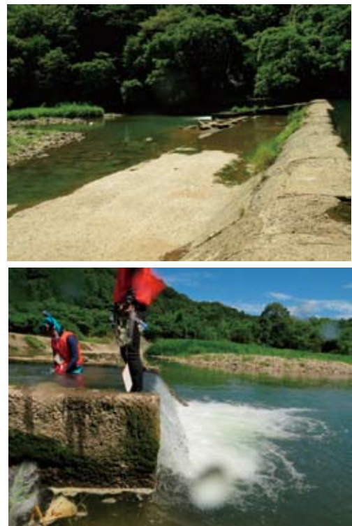
図7. 入原地区の堰堤と魚道の入り口にできた段差（下）。
