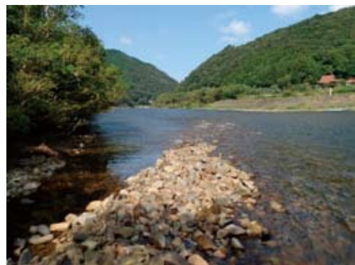
図12. 長良の瀬の左岸側にみられる導流堤の痕跡.
