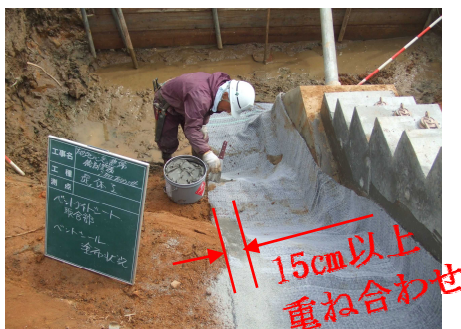
ベントナイト系遮水シート同士の接着剤(ベントシール)塗布状況
