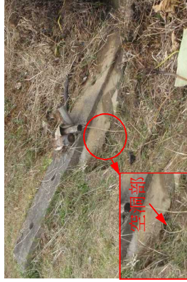
取水施設(斜樋)の老朽化状況
