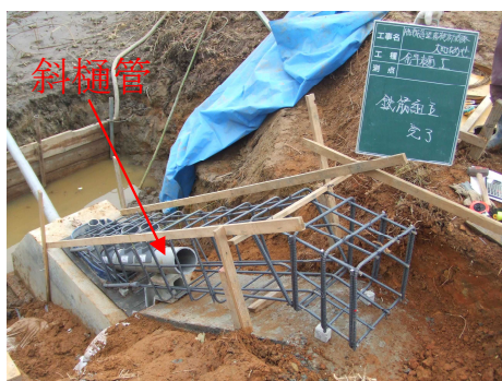
⑧斜樋:VP管φ150、鉄筋組立状況
