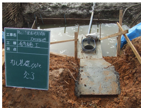
⑥斜樋:基礎コンクリート状況
