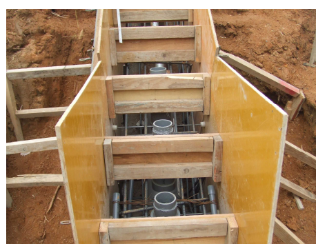
⑨斜樋:取水孔VP管φ75mm設置状況
