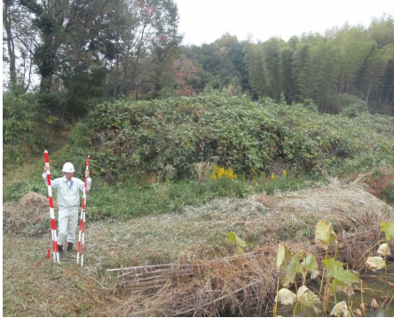
土取場:ため池付近の地山
