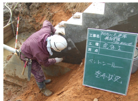
構造物の接着剤(ベントシール)塗布状況
