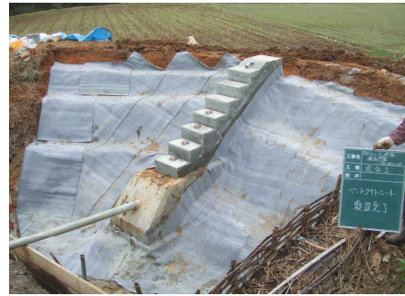
ベントナイト系遮水シート敷設状況
