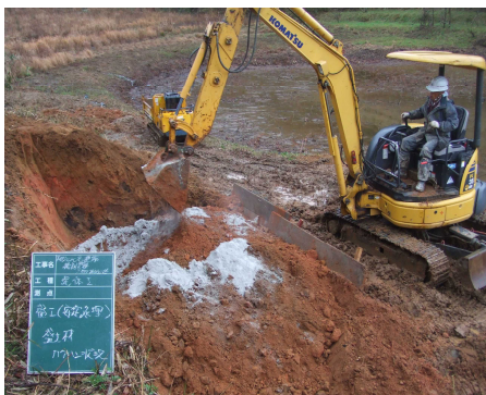
セメント混合状況
