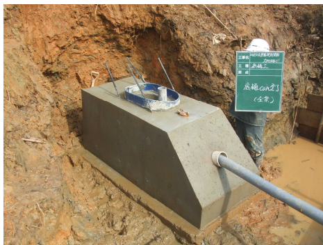
⑤底樋取付:完成
