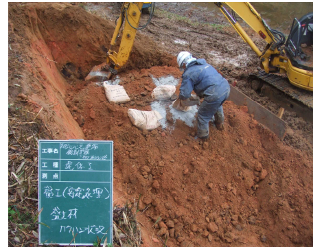
セメント散布状況
