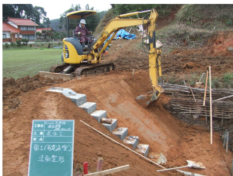
盛土法面仕上状況
