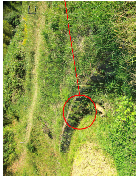
下流法先ブロック(空積)目地からの漏水状況
