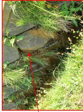
下流法先ブロック(空積)の状況
