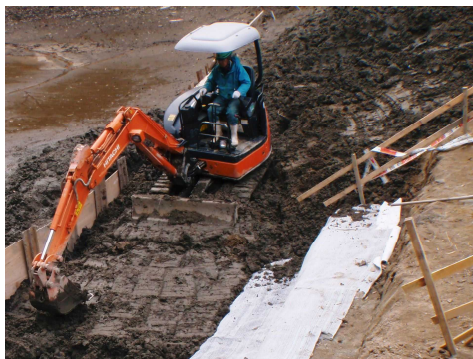
まき出し・敷均し状況
