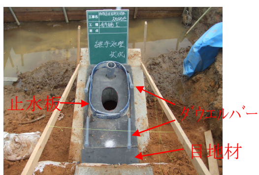
⑦斜樋:継手材設置状況
