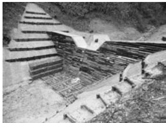
(間伐材型枠を残置した治山ダム)
