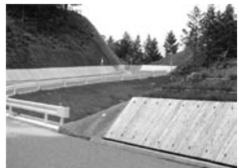
〔法尻に間伐材を使用した間伐パネル〕
