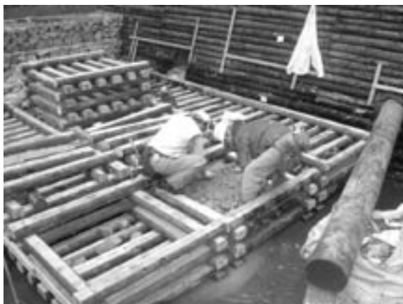
(方格材として間伐材を使用し、詰石に自然石を利用)
