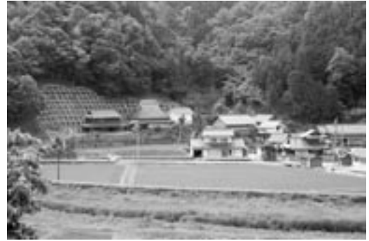
山地災害危険地区における治山工事
