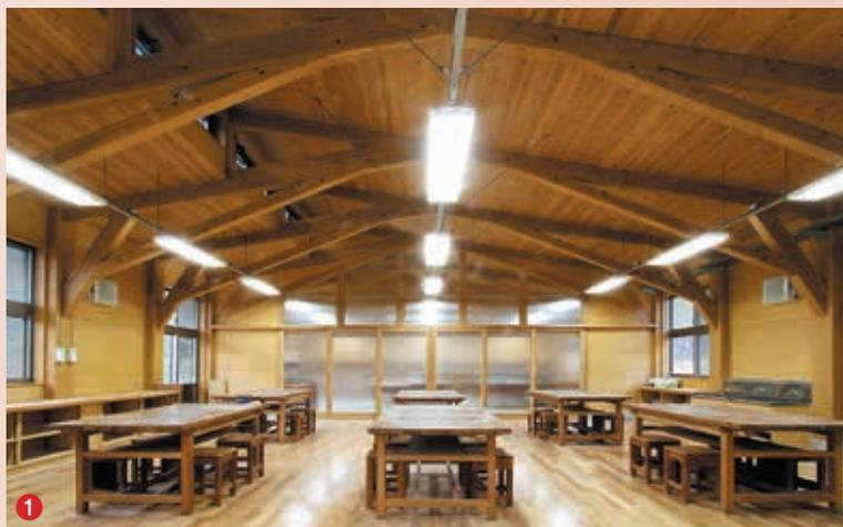
この建物は中学校の技術(実習)棟で、耐震性が著しく低い鉄骨の既存建物を解体撤去し木造で改築をした。
