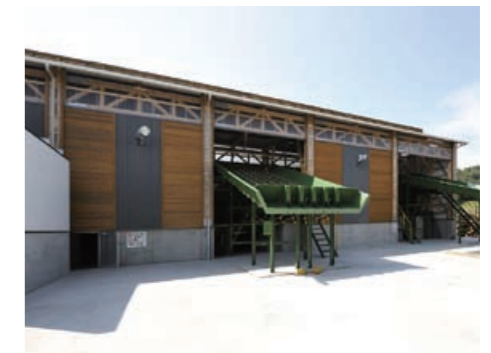
写真右上から 正面全景 工場内全景 工場内：梁、柱部分より採光 外観：柱、梁部の仕上げによる木軸躯体表し
