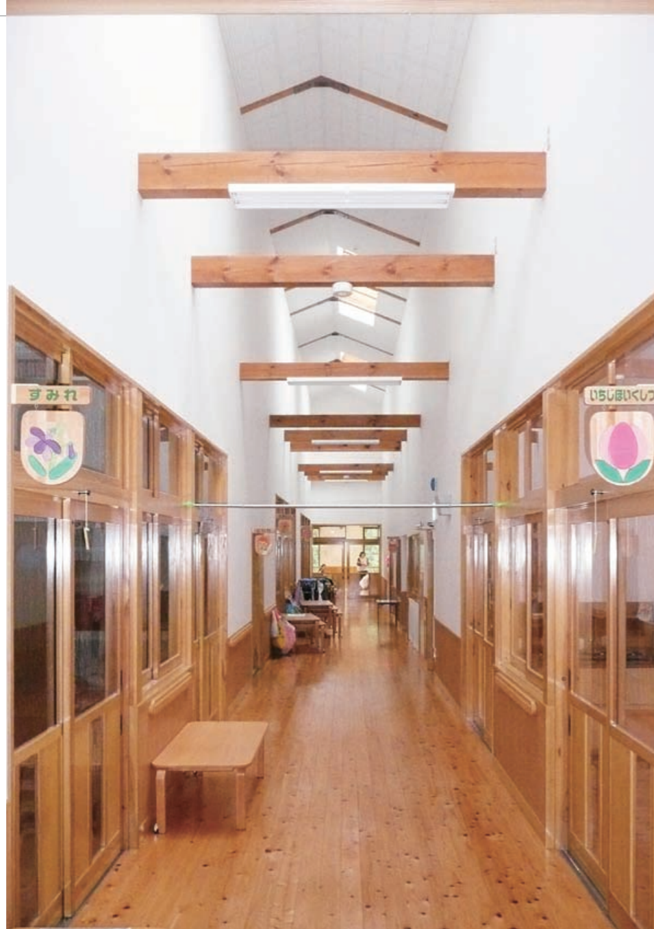
梁をあらわし天井を高く取った廊下
