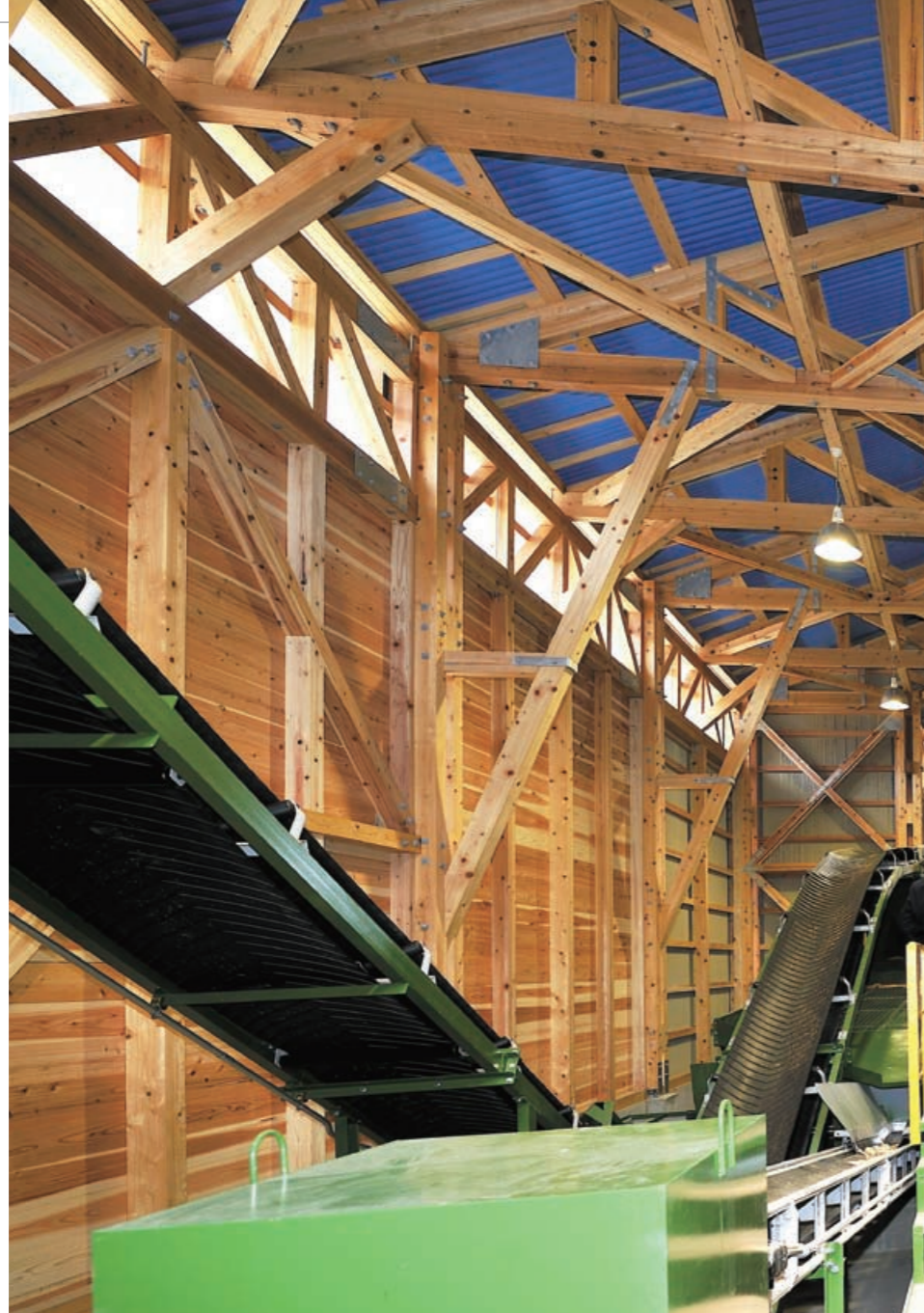
工場内：木組み現し
