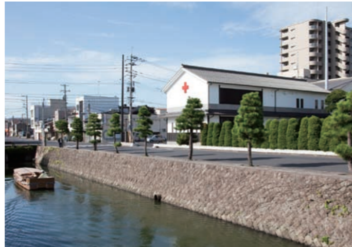
堀川越しにみる白壁土蔵風外観
