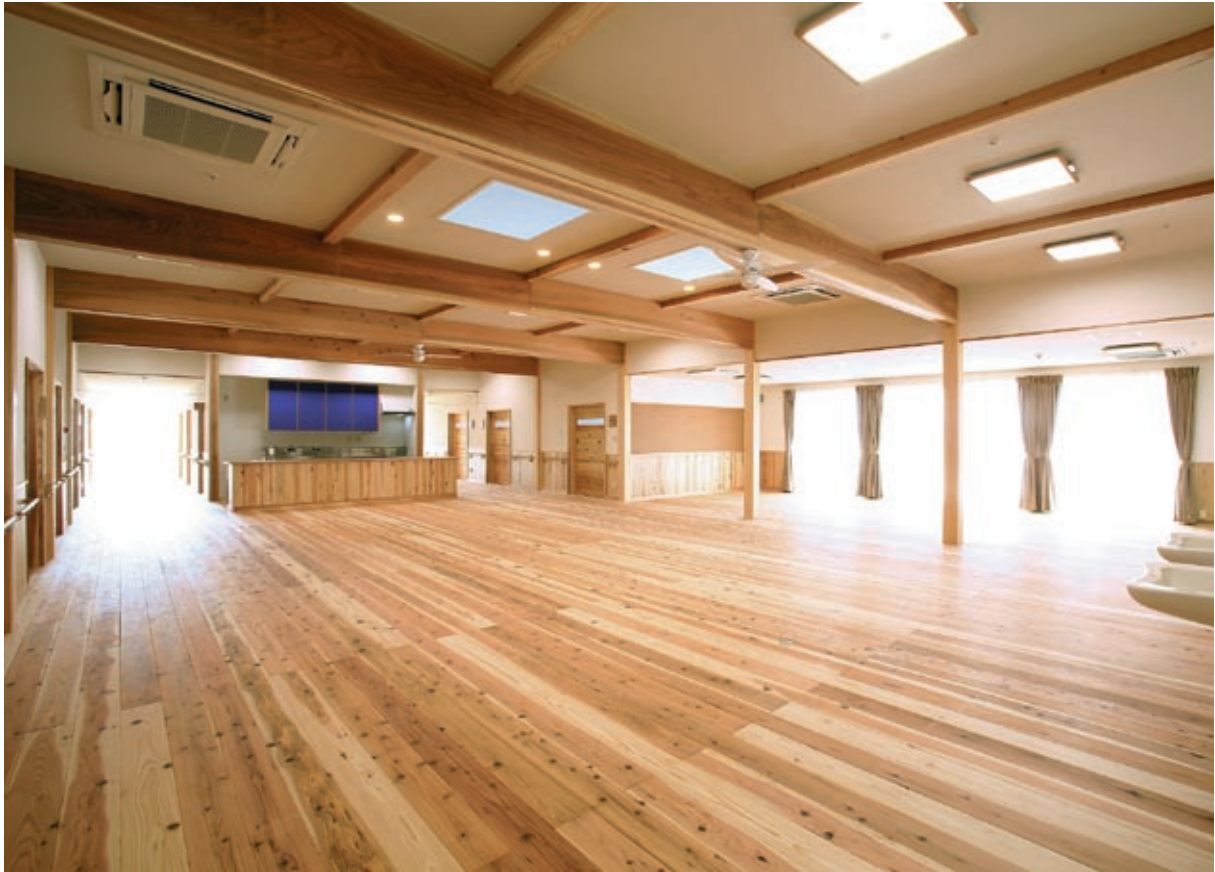
内装・建具に島根県産の杉無垢材を使用した食堂・娯楽室
