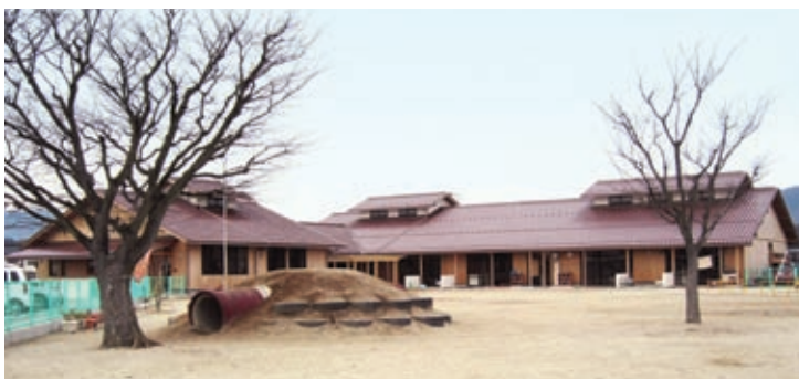
来待色の瓦大屋根と杉板貼の外観
