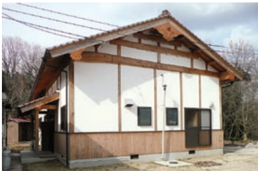
伝統構法にこだわり建てられた古民家風の外観
