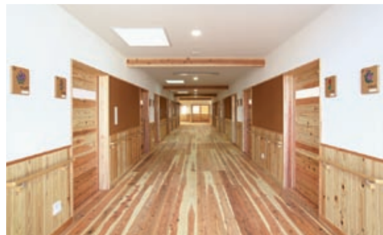
腰壁・床仕上げに島根県産の杉無垢材を使用した廊下
