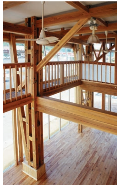
スギ材の「合わせ梁」と150角の「4本組柱」 フローリングには隠岐産のマツ材を使用
