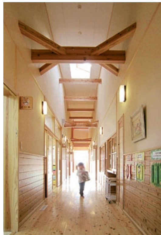
越屋根からの採光と通風を確保した吹き抜けのある中廊下
