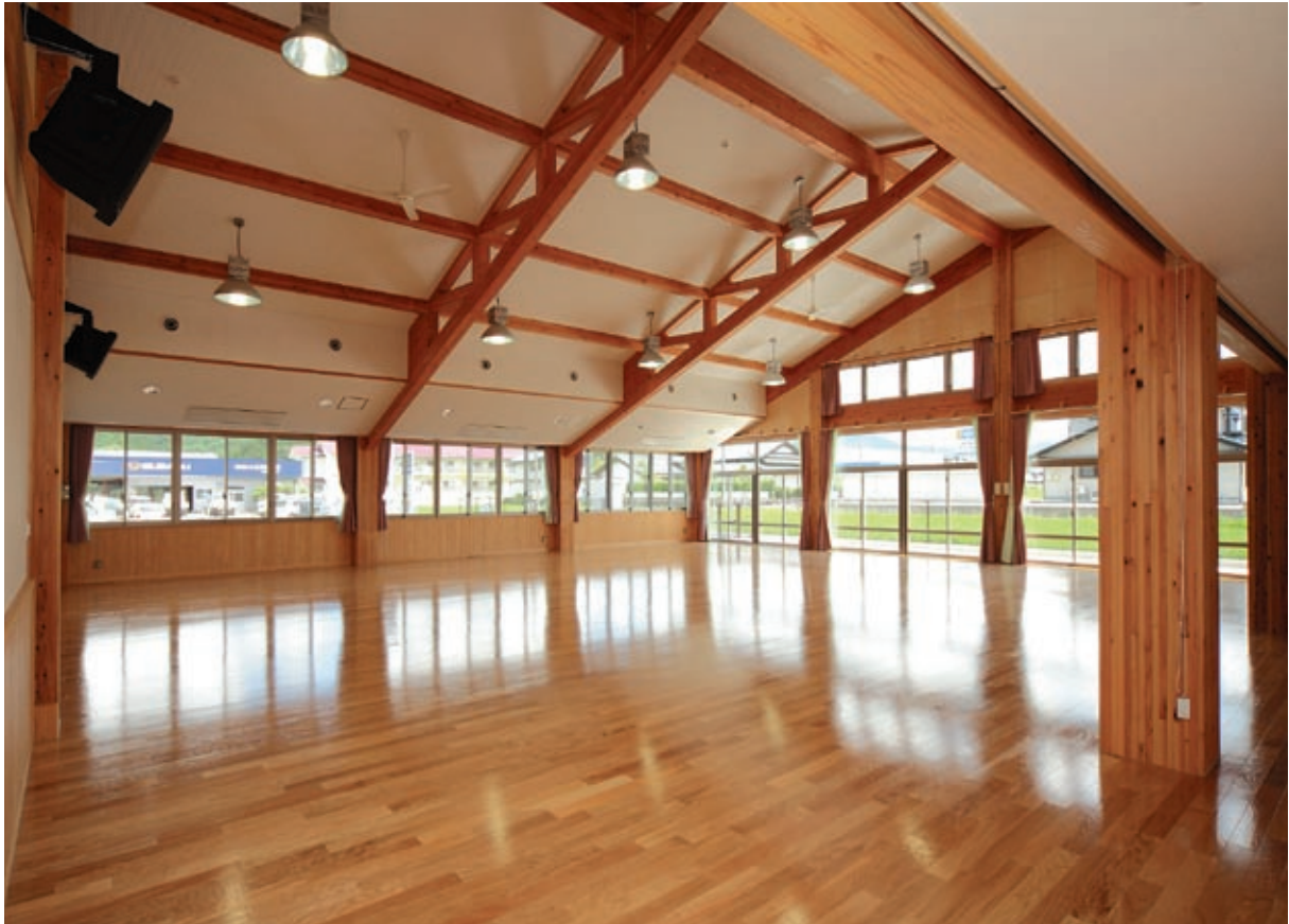
集成材による長スパンのトラスが現しの遊戯室
