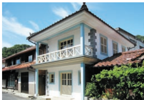
改修工事後の外観
