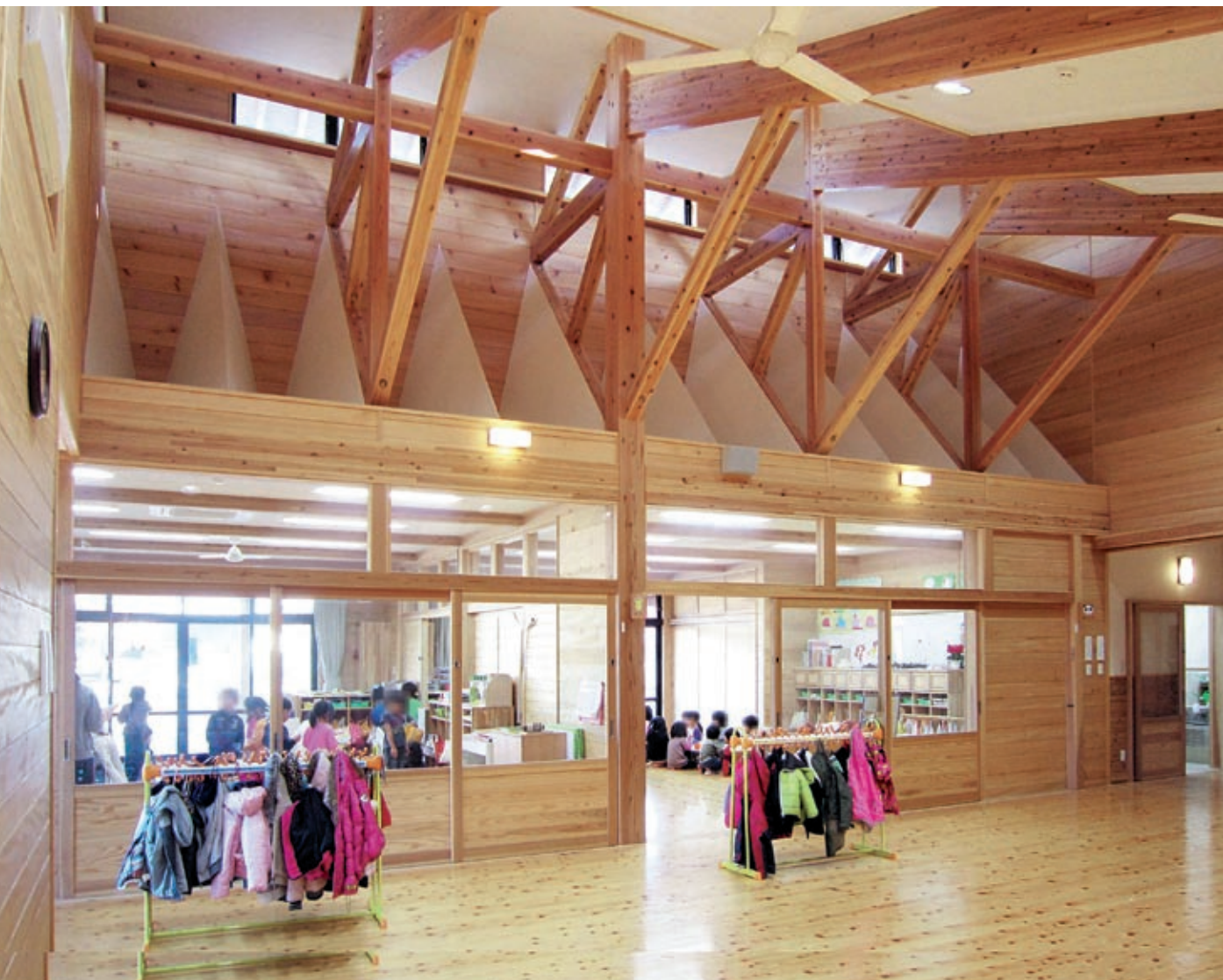
柱・梁等を可能な限り見える化した保育室と遊戯室
