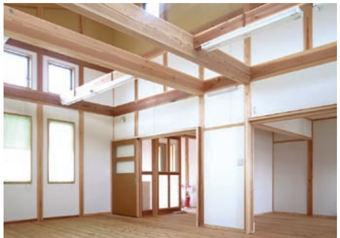
島根県産のスギ材を主に使用した真壁造り
