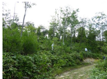
作業終盤の状況
