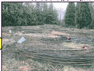
老朽ハウス撤去
