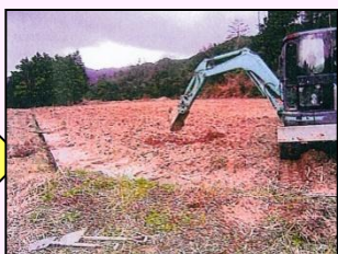
再生作業中(整地)
