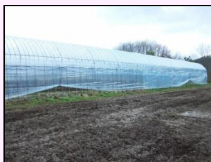
ハウスの修繕
