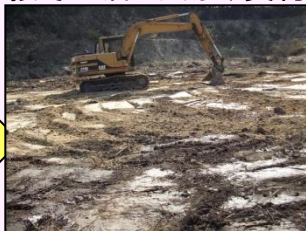
再生作業中(整地)
