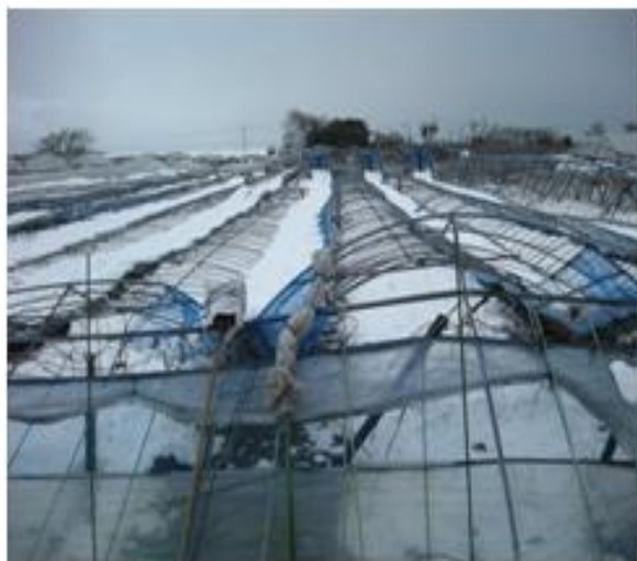
ぶどうハウス全壊 (安来市)
