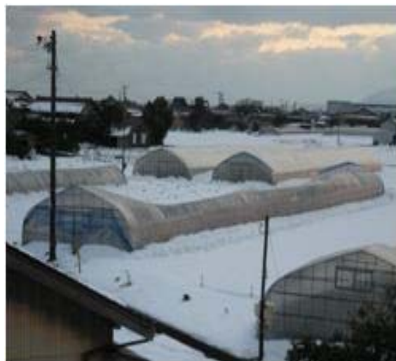
いちごハウス全壊 (安来市)
