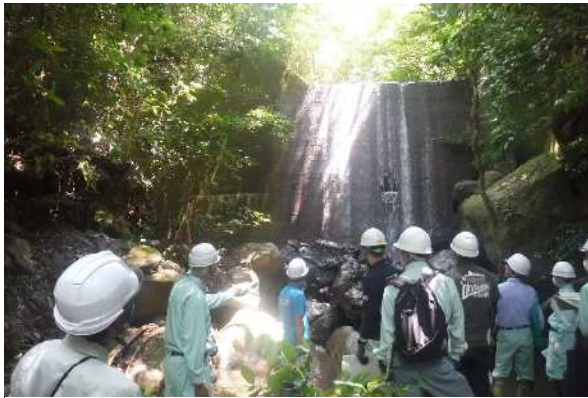
谷止工（コンクリート製）の点検中
