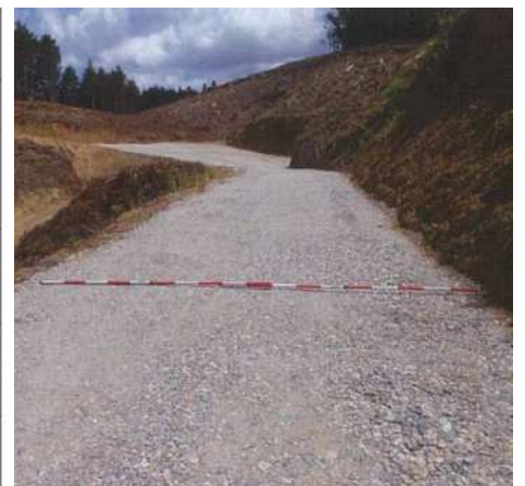
中規格作業道の完成横断
