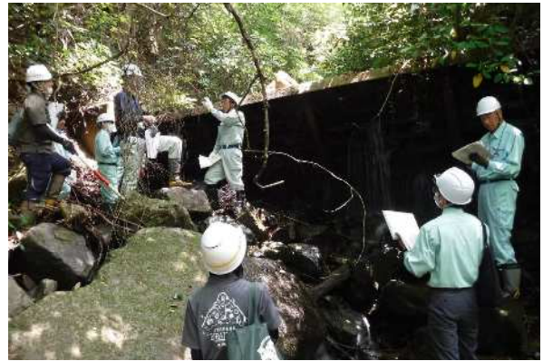
谷止工（鋼製）の点検中
