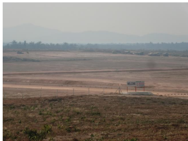
SEZ 内 整地が進んでいるエリア
