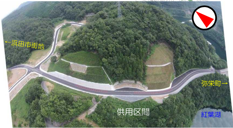
完成状況写真
