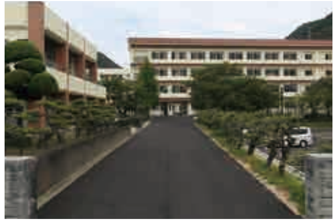
平成27年7月に完成した新校舎
