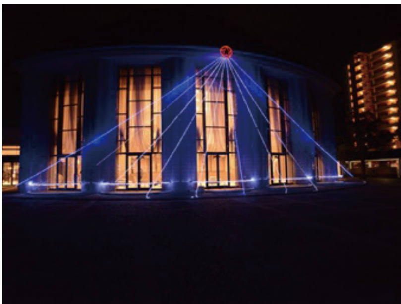
電子制御で美しく変化するイルミネーションの設置
