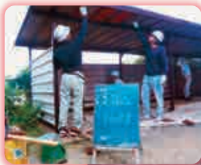
近隣中学校の自転車小屋の塗装の様子
