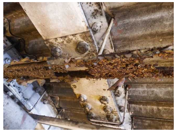
照明取付レールの断面欠損、破断
