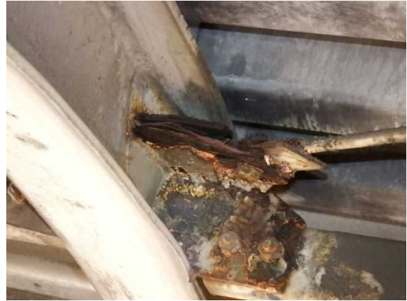
ガセットプレート部分の腐食
