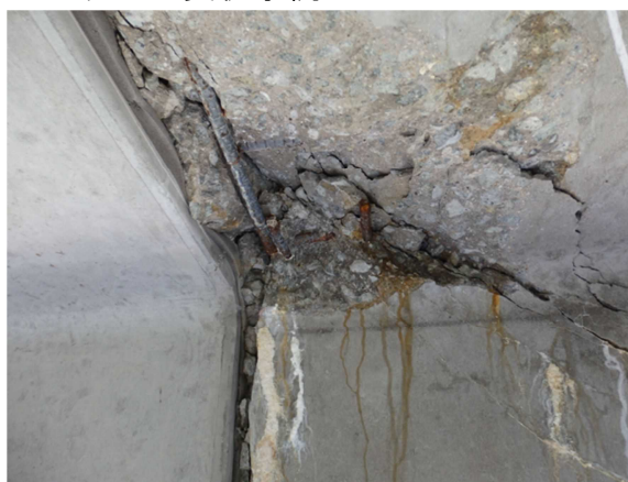
はく落を伴う鉄筋露出（頂版）
