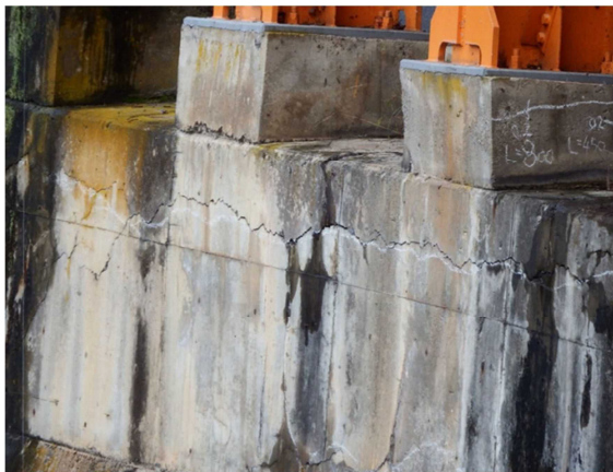
受台のひび割れ
