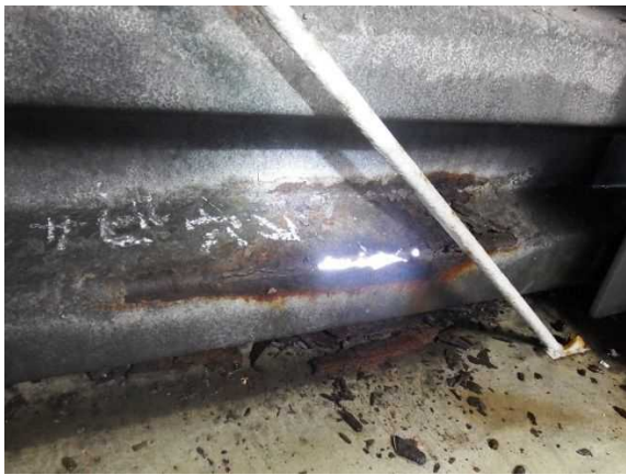
頂版の断面欠損
