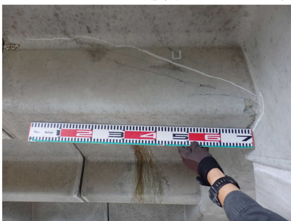
ひび割れ、はく離・はく落（横梁）
