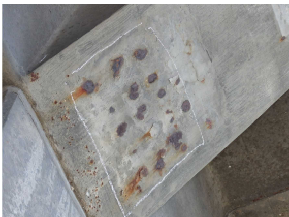
PC 鋼材からの錆汁（主梁）
