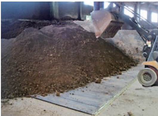
生ごみリサイクル工場 （埼玉県）
