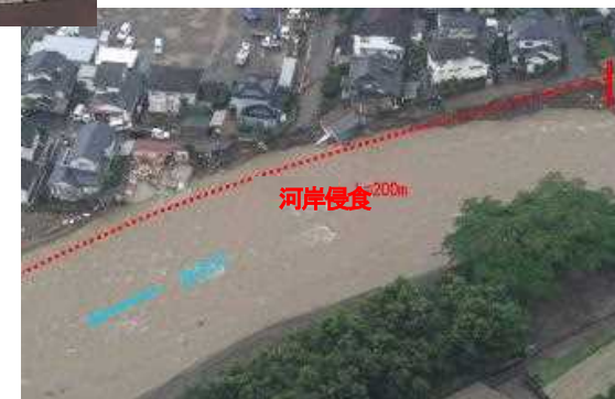
河岸侵食に伴う 家屋倒壊等
