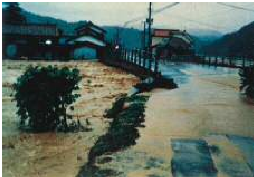
昭和63年7月洪水（浜田市上府町 府中橋）
