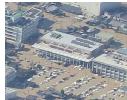
平成27年9月 関東・東北豪雨 防災拠点である常総市役所も浸水
