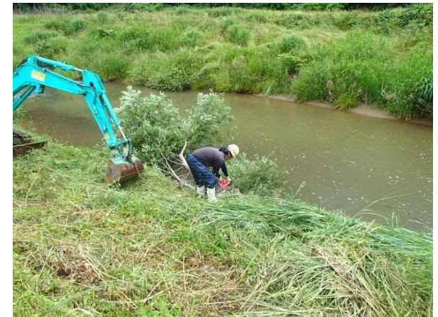
支障木等の撤去状況(都治川)
