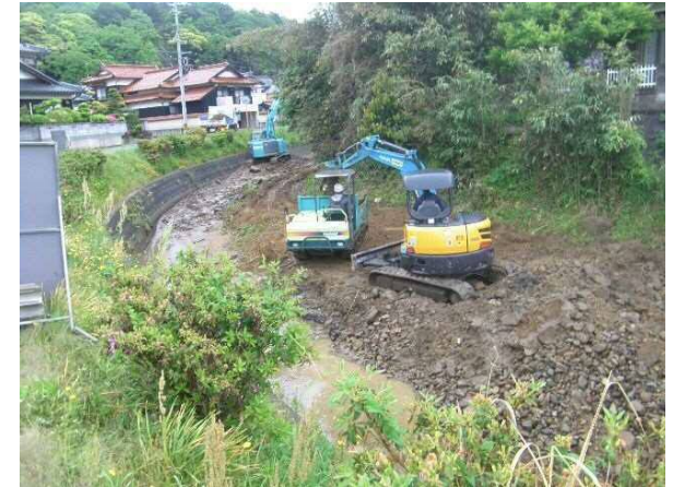
堆積土砂の撤去状況(新川)
