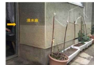
家屋等の浸水痕跡
