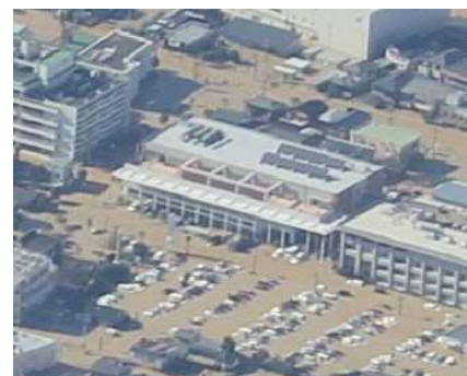
平成27年9月 関東・東北豪雨 防災拠点である常総市役所も浸水
