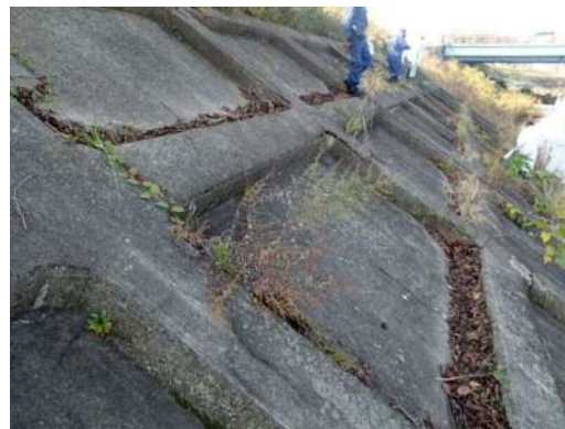
現地点検状況
