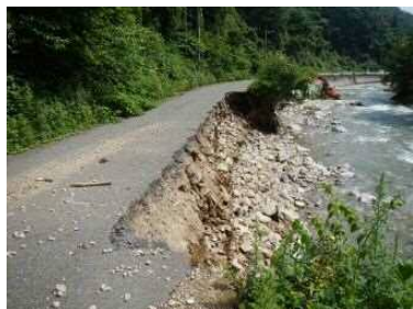
上流域の被災状況
