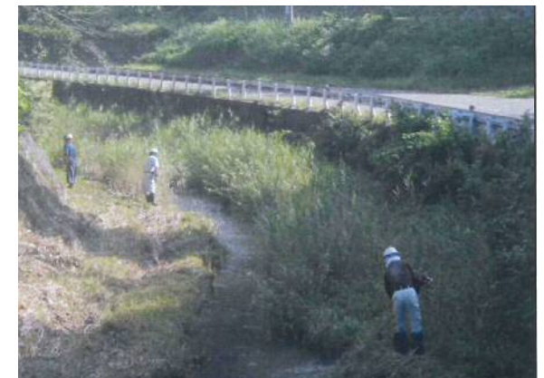
堆積土砂の撤去状況
