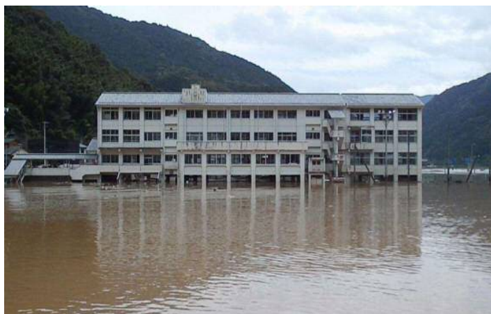
平成26年8月 避難所2階の浸水 (徳島県)
