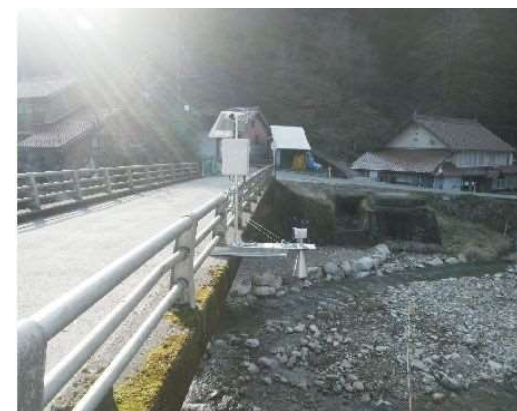
浜田市 周布川 栃下橋
