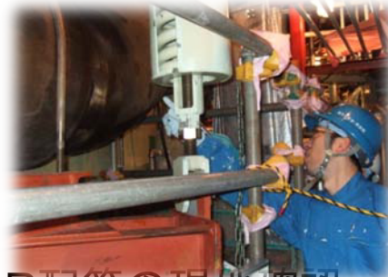
PLR配管の現地確認
