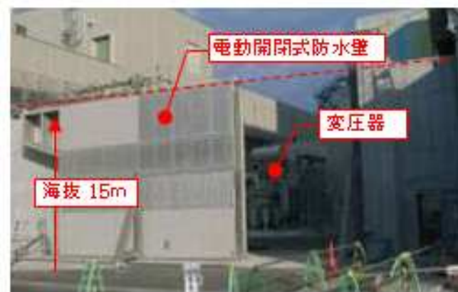
3号機変圧器エリアの防水壁 (H23.12完成)
