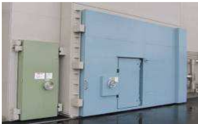
3号機建物外壁に設置した水密扉
