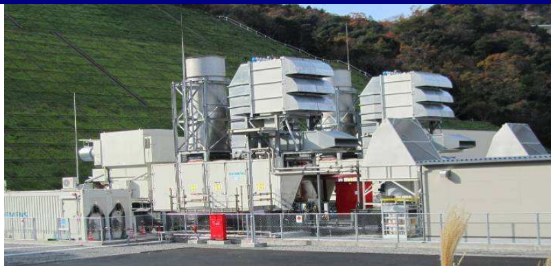
据付後のガスタービン発電機
