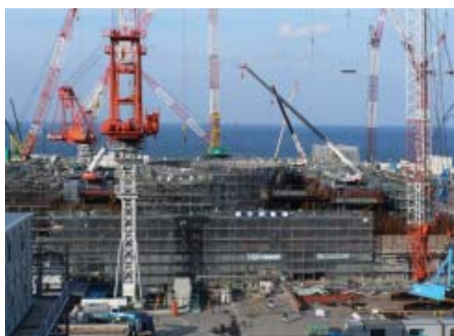
建設中の3号機 (平成23年12月営業運転開始予定)
