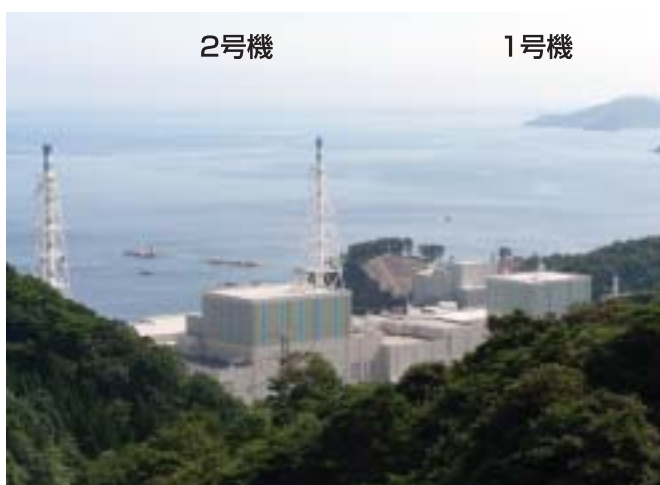
島根原子力発電所1・2号機
