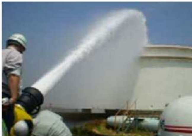
大容量泡放水砲システム
