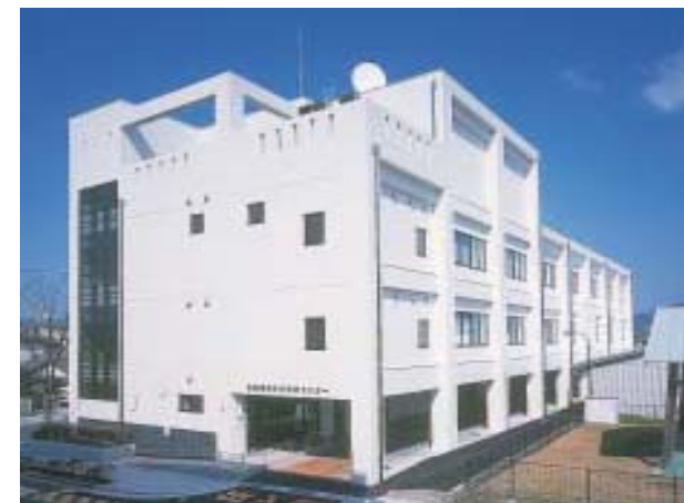
島根県原子力防災センター （オフサイトセンター）
