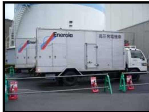
高圧発電機車(500kVA)2台
