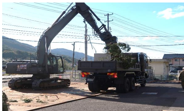
道路啓開訓練(11/7)
