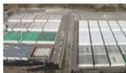
低レベル放射性廃棄物 埋設センター 1992年操業開始
