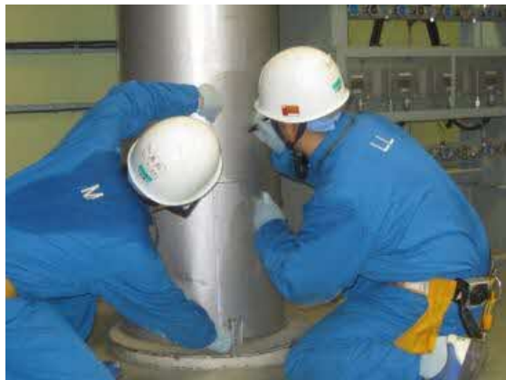
汚染状況の調査 (線量率測定箇所マーキング【完了】、 現在、データ取りまとめ中)
