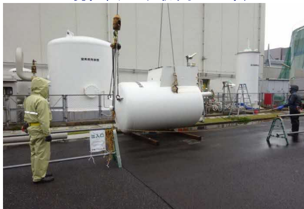
放射線管理区域外にある役目を終えた設備の解体撤去 (窒素ガス制御系設備の撤去【完了】)
