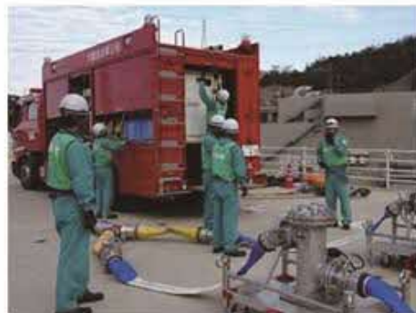
大量送水車を用いた送水訓練
