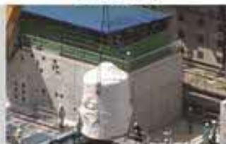
フィルタ付ベント設備
