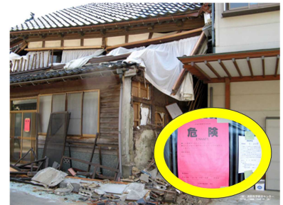
倒壊の危険がある住宅と応急危険度判定結果 （出典：（一財）消防科学総合センター）
