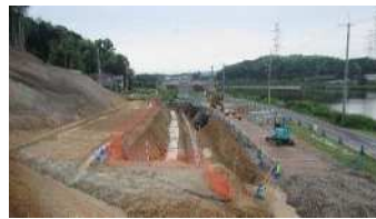
護岸工、付替道路工 (朝酌矢田地区) R5年7月
