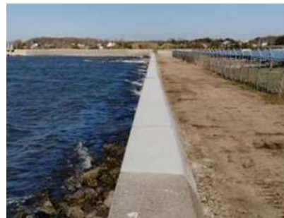
米子市(葭津) 完成(R5年3月)
