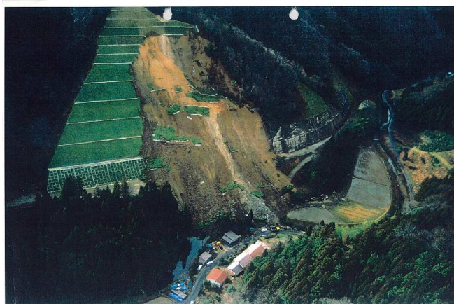
法面崩壊状況
