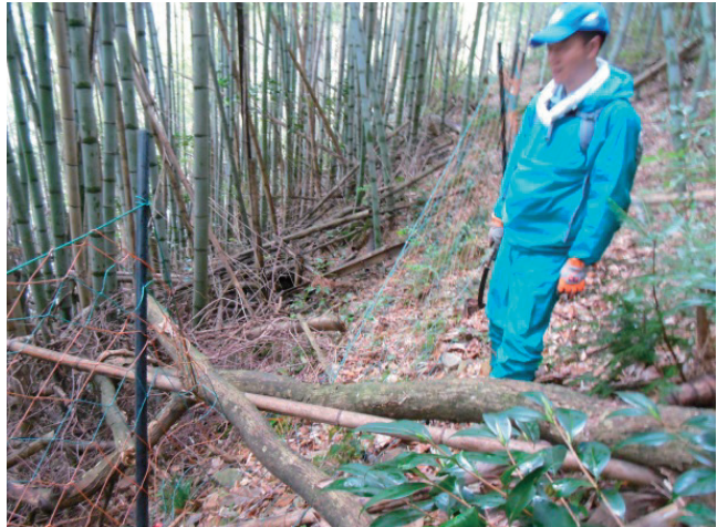
写真6 倒木によって漏電している広域電気柵 (2013年)
