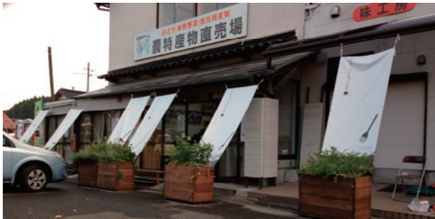
写真7 改修3ヶ月の状況（タープ、植栽コンテナ）
