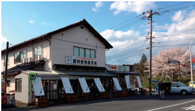
写真8 改修3ヶ月の状況（店先ファサード）
