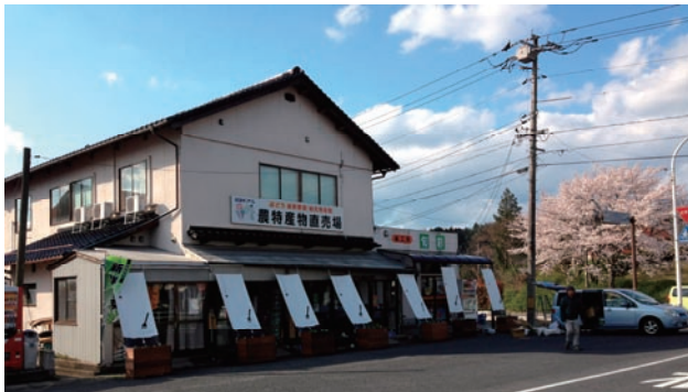
写真8 改修3ヶ月の状況（店先ファサード）
