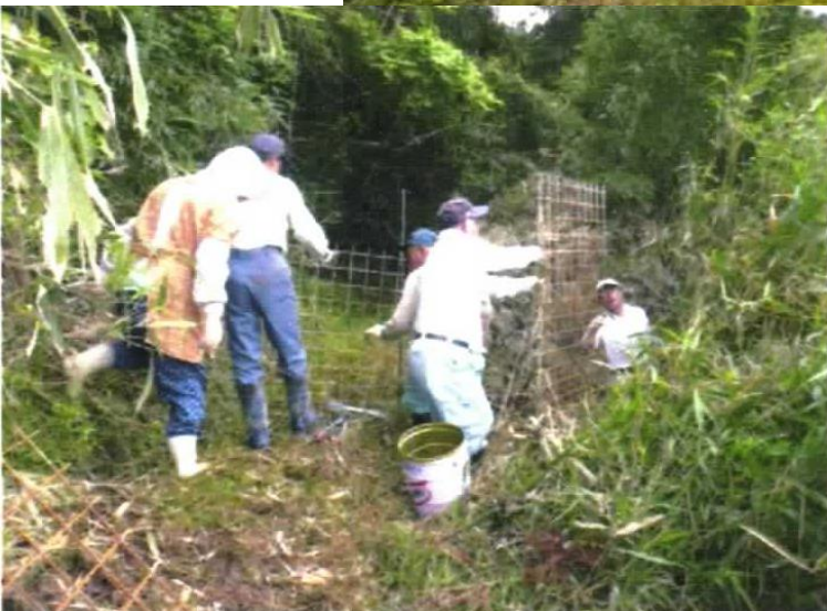
出合い作業で集落全体 に防止柵を設置
